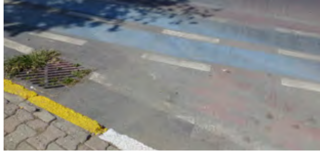
Şekil 81 Kısa bir bölümde kaldırım bulunmuyor
