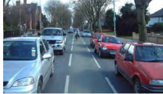
Fotoğraf 1: Tampon Alana Sahip Ayırıcısız Bisiklet Yolu ve Merkezi Ayırıcısız Bisiklet Yolu
