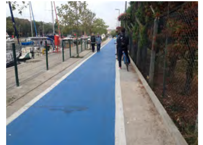
Şekil 135: Kurbağalıdere Boyunca Daralan Enkesid Ortak Kullanımı
