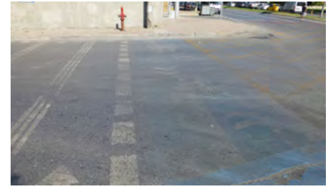
Şekil 69 Yüksek hızlara izin veren geçiş yolu
