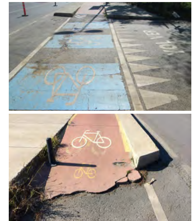
Şekil 99 Bisiklet yolu üzerindeki deformasyon
